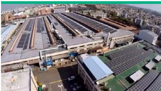
東元電機盤點用電5MW以上廠區，2020年超前部署投資台幣1.05億於中壢廠建置1.7MW太陽能系統，預計年發電量為200萬度，提前完成10%綠電建置。2021年起已經併網發電。
