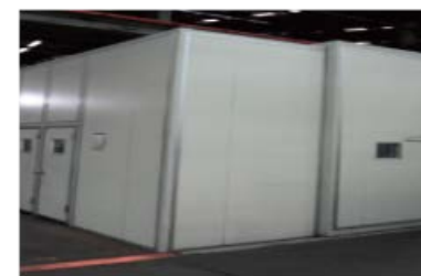
中壢廠區連續沖床噪音防制阻隔改善
