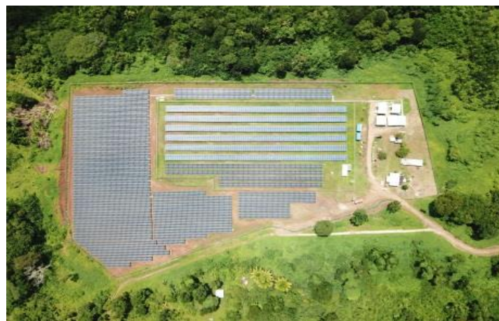
儲能系統工程
